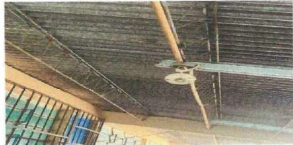
Foto 6: Instalacion de energia electrica en mal estado se necesita cambiar cables.
